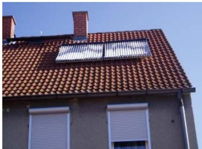
Auch im Winter geben die Hochleistungskollektoren, die einen Jahresdurchschnitt von bis zu 60% der benötigten Energie für Heizung und Warmwasser über die Sonne abdecken, noch Energie an den Speicher ab. Sobald Licht auf die Kollektoren fällt, beginnt die Solarthermische Anlage zu arbeiten und pumpt die Restwärme in den Kreislauf.
